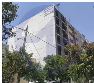
پروژه آقای غلامی شیراز - قدوسی شرقی
