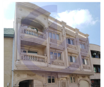
پروژه آقای قندی شیراز-قصرالدشت
