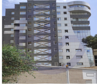
پروژه ساختمان اساتید شیراز - بلوار معالی آباد
