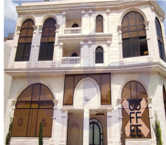
پروژه آقای بیدشهری شیراز - بلوار نبایش
