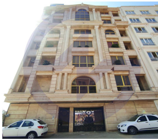
پروژه آقای مهبودی شیراز-فرهنگ شهر
