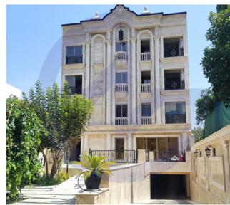
پروژه آقای کاظمی شیراز-همت جنوبی
