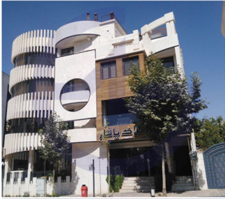
پروژه آقای کشاورز شیراز - بلوار نبایش
