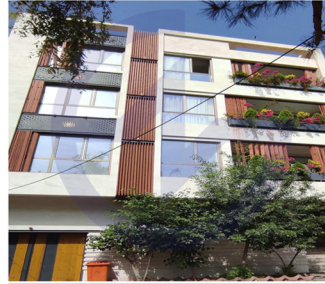
پروژه آقای مهبودی شیراز - فرهنگ شهر
